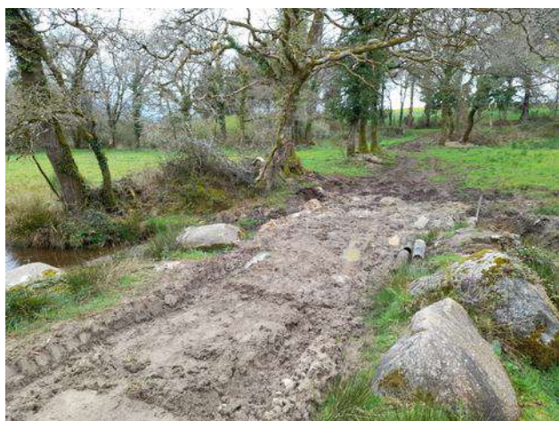
Figure 5: Terrassement en zone humide (aménagement passage busé)
