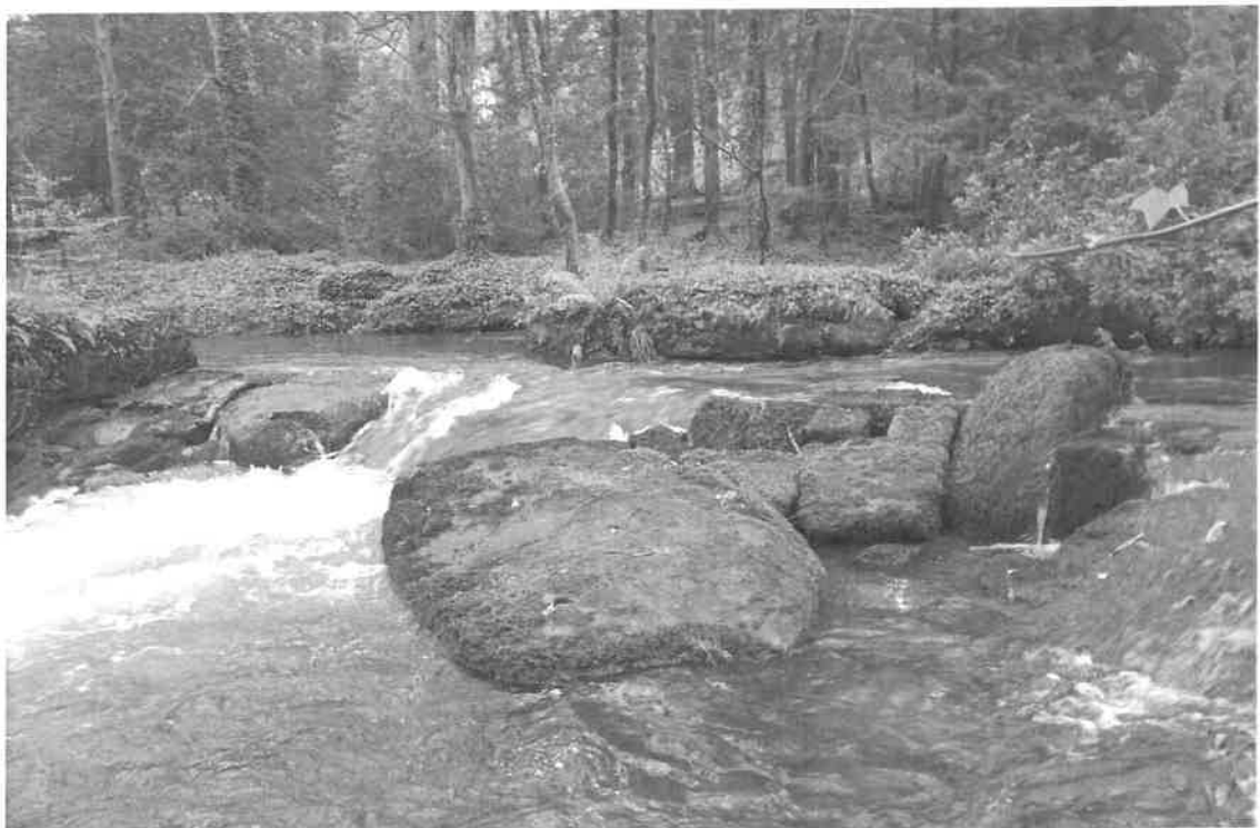
Seuil de séparation de la rivière et du bief.
