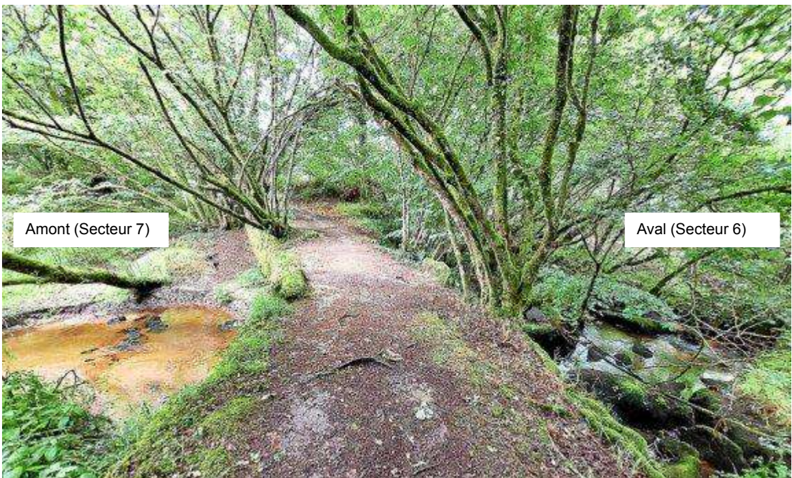
La digue de l'ancien étang du Corong
