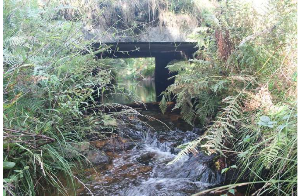
Point 6 : Le Roudouhir au niveau du pont routier sur la RD 42
