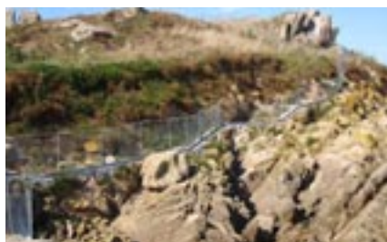
Clôture anti-vison d'Amérique installée en 2009. Impenetrable fence build in 2009.
