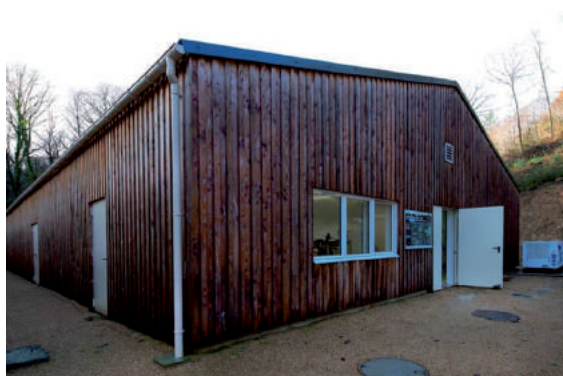
Bâtiment d'élevage des mulettes.
