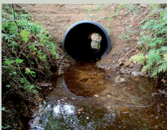
Remplacement d'une buse, sous-dimensionnée et provoquant un obstacle infranchissable pour les poissons, par un Ecopal, sur un affluent du Loc'h.
