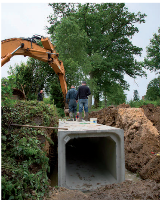
Installation d'un pont-cadre sur un affluent de la Rouvre.
