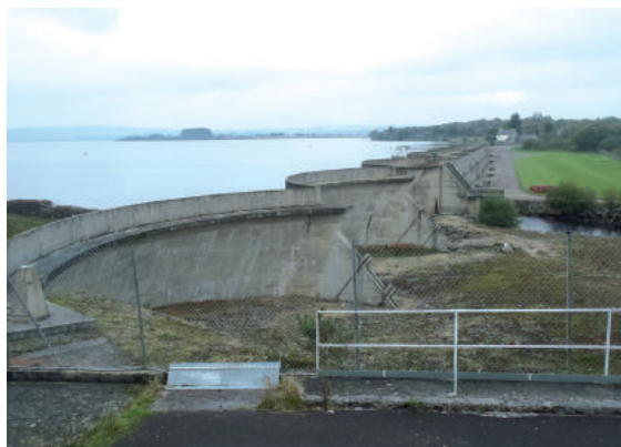
Barrage de Nestavel sur le cours principal de l'Elez.
