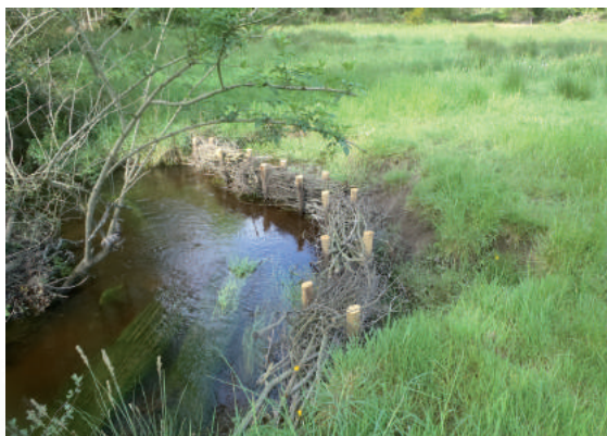
Restauration d'une berge altérée par un abreuvement (à gauche) par la réalisation d'un fascinage en saule (à droite), sur le Bonne Chère.
