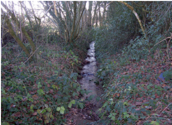
Remise en fond de vallée du ruisseau de la Croix-Sellos, sur le bassin du Sarthon (avant/après).
