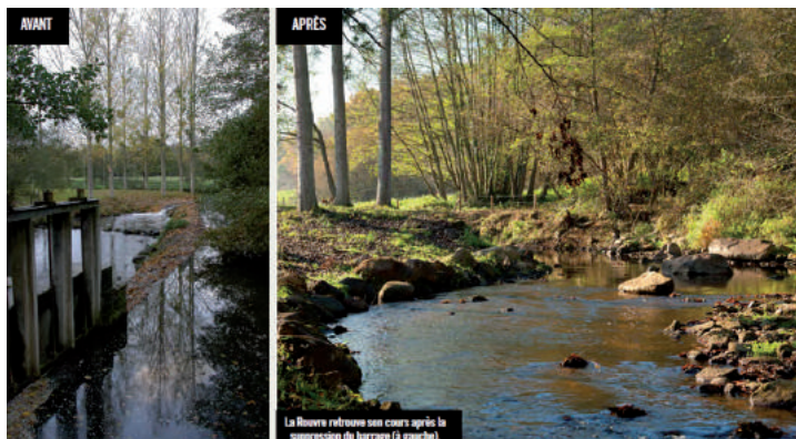
Suppression d'un seuil de moulin, sur la Rouvre.
