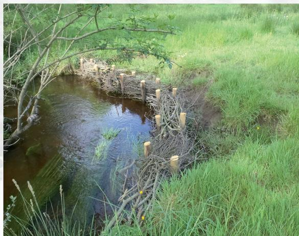
Restauration d'une berge altérée par un abreuvement (à gauche) par la réalisation d'un fascinage en saule (à droite), sur le Bonne Chère.
